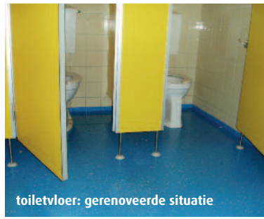
kunststofvloer met afschot in badkamer
